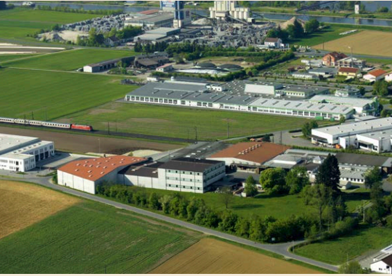
Production site Altendorf
